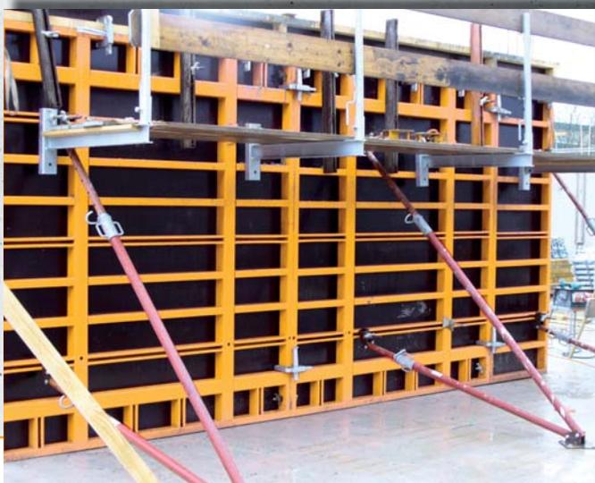
Pour solidariser les éléments entre eux, deux serre-joints rapides suffisent. La résistance à la rupture est telle que seuls deux points de serrage par élément sont nécessaires pour pouvoir déplacer les coffrages, même les plus grands.
