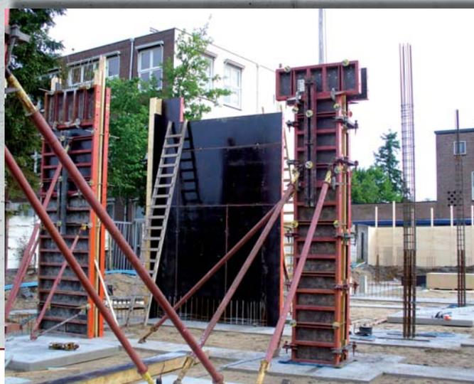
Les tracés plus complexes se laissent coffrer avec facilité grâce aux éléments standard. Les murs alignés d'un seul côté sont coffrés avec la console de support FEBE.
