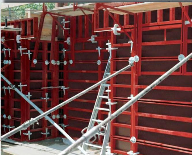
Grâce à l'utilisation d'éléments de différentes dimensions, chaque plan se laisse coffrer, même lors du coffrage de grandes surfaces.
