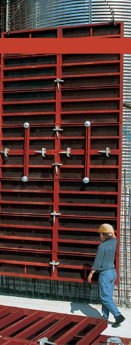
Installation d'une structure de coffrage préalablement assemblée à l'horizontale. Les entretoises ne servent qu'à renforcer la stabilité de l'ensemble lors de la mise en position.
